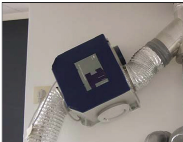
Afb. 13 Ventilatieunit voor enkel mechanische afzuiging
