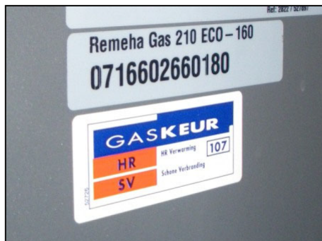
Afb. 9 CV-ketel met HR keur (HR107)
