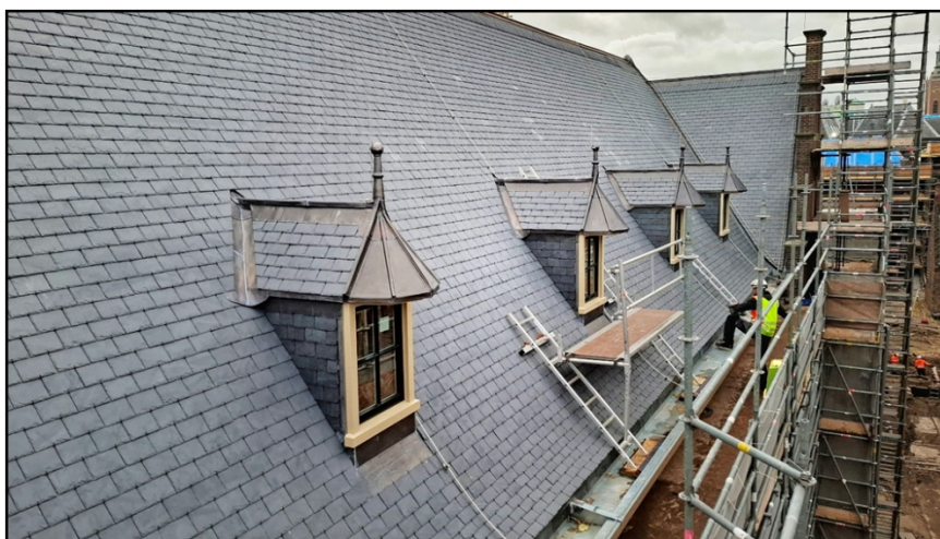
Het vervangen van 20.000 m 2 aan dakleien vraagt om schaars specialistisch personeel
