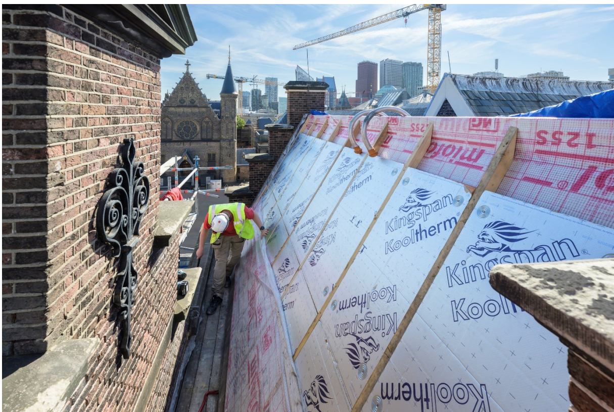
(Afbeelding 6: Renovatiewerkzaamheden Raad van State)
