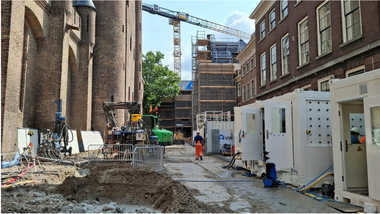
(Afbeelding 10: funderingsversterkingen Grafelijke Zalen)
