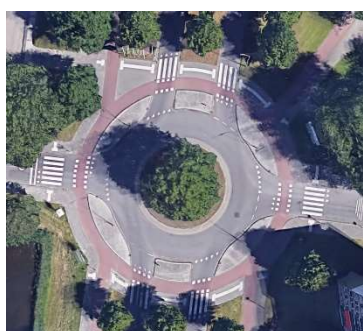
Fietspad rond rotonde
