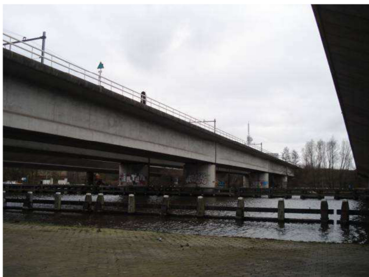
Figuur 23: De huidige spoorbaan tussen de rijbanen van de A10 537
