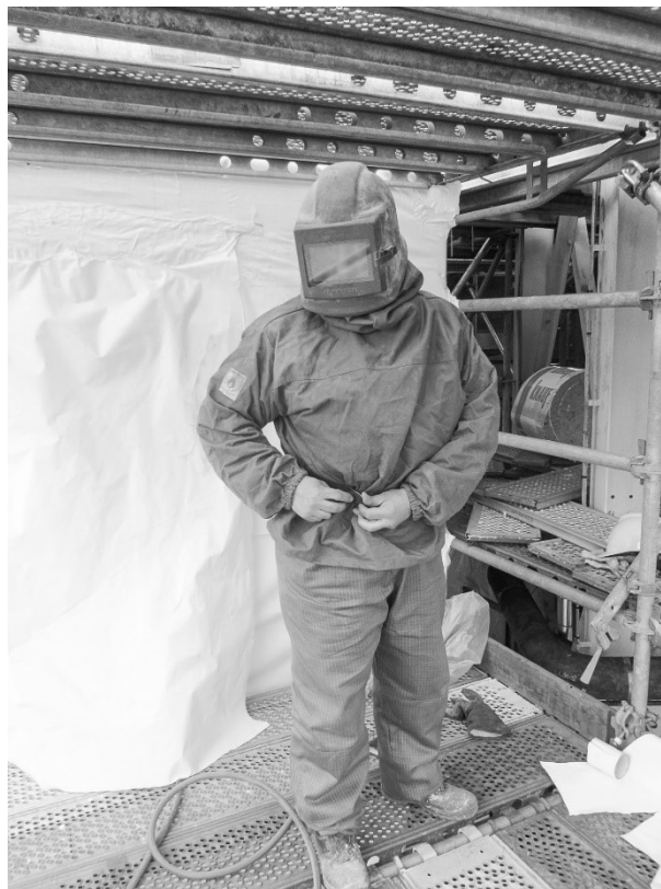
Meetlocatie 1B: Beschermende kleding, inclusief straalkap, zoals gedragen door straler tijdens straalwerkzaamheden
