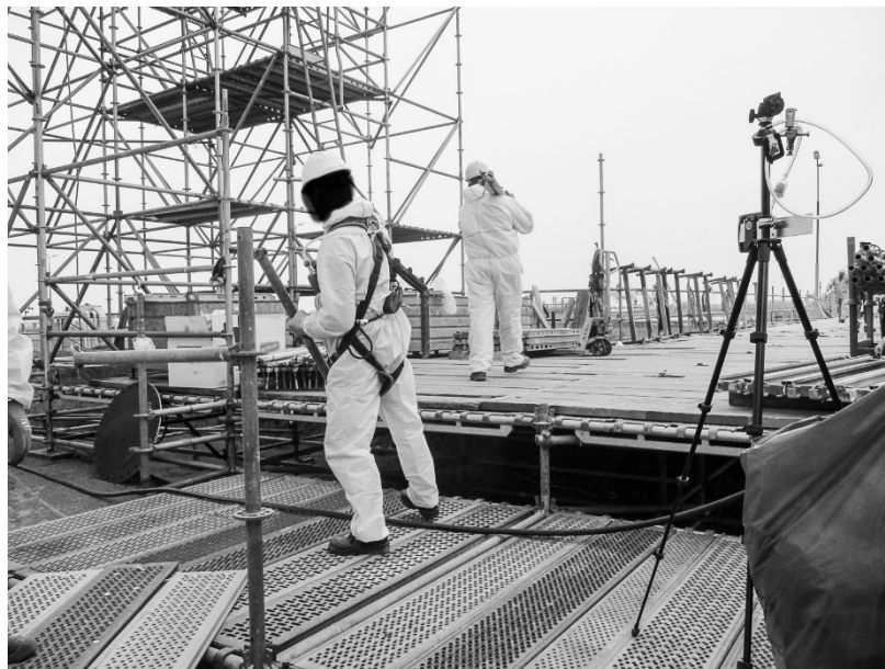
Meetlocatie 1C: Annemen en opstapelen steiger materiaal, inclusief positie stationair meetpunt (vlakbij mangat)
