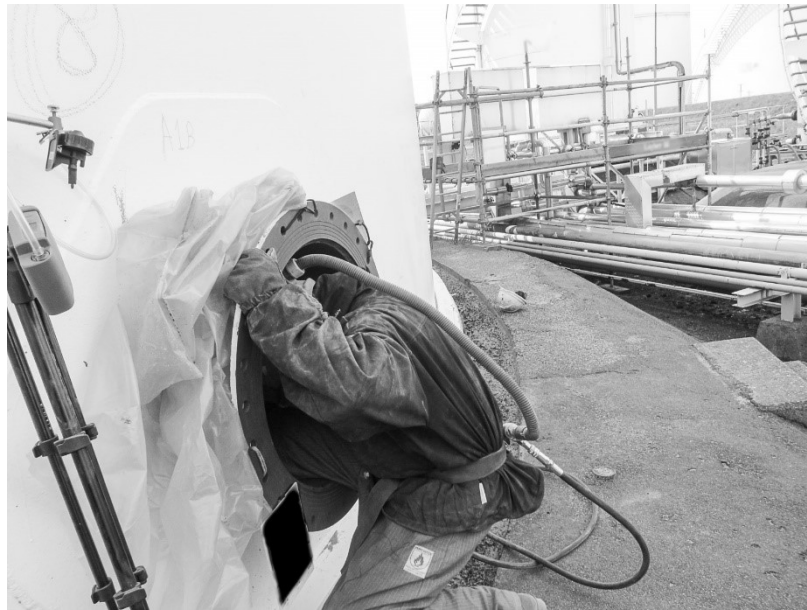
Meetlocatie 1C: Betreden van tank via mangat
