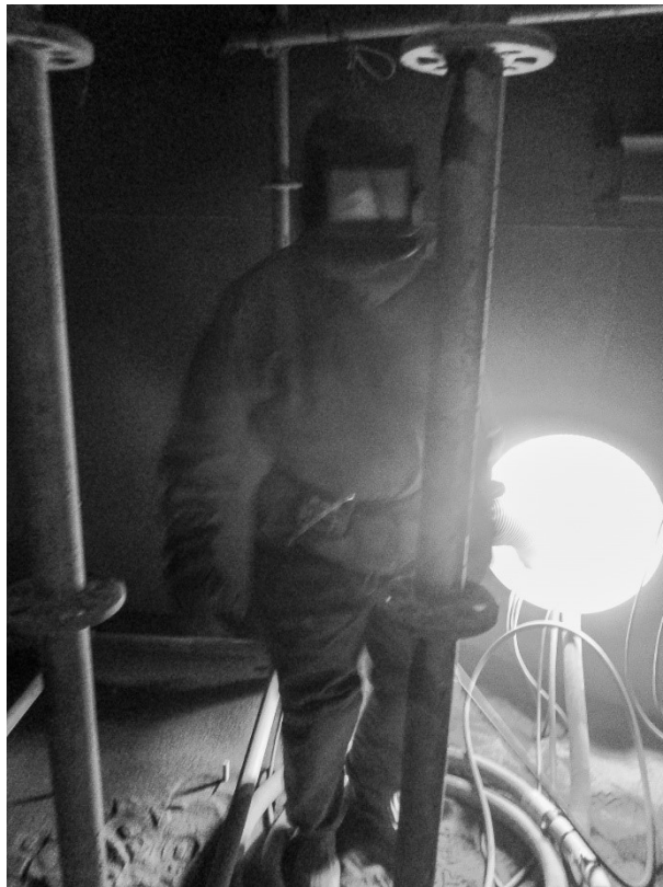
Meetlocatie 1A: Persoonlijke meting bij straler in tank, inclusief beschermende kleding en straalkap
