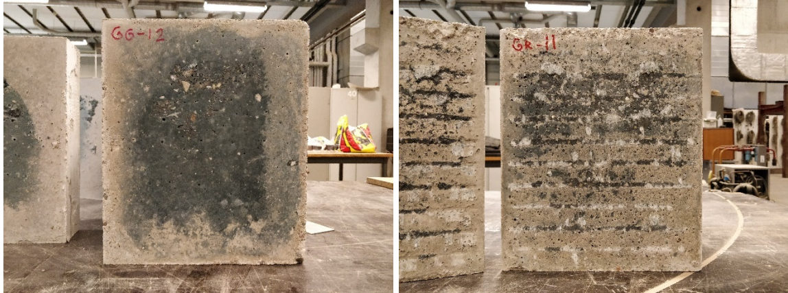
foto 16a en b Bezweken aansluitvlakken van zelfverdichtend beton glad (a) en opgeruwd (b)
