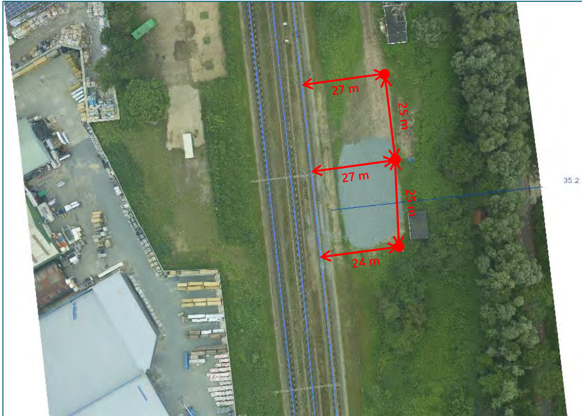
Afbeelding I.3 Meetlocatie Zaltbommel (let op: de bult met grondmateriaal (grijs) was tijdens de meetperiode niet aanwezig)
