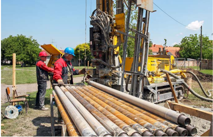
Het aanboren van een geothermiebron. Foto: PureBudget
