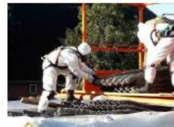
Foto: Golfplaten in container schuiven
