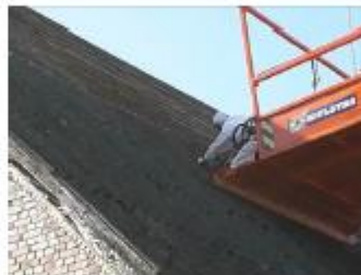
Foto: Golfplaten los schroeven
