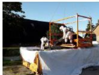
Foto: Golfplaten in container schuiven
