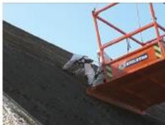
Foto: Golfplaten verwijderen
