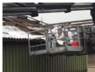
Foto: golfplaten verwijderen
