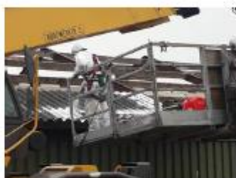
Foto: golfplaten inspuiten met schuim
