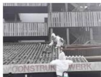
Foto: Nokvorsten naar beneden schuiven
