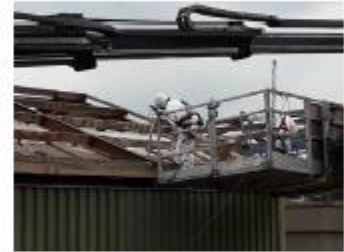
Foto: stofzuigen spanten
