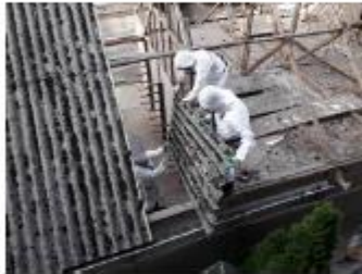
Foto: Golfplaat doorsteken
