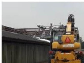
Foto: golfplaten inspuiten met schuim
