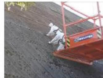
Foto: Golfplaten losschroeven en restanten verwijderen
