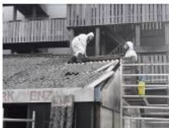
Foto: Golfplaten verwijderen
