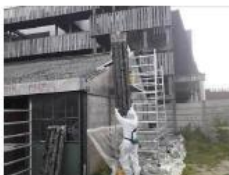
Foto: Golfplaat langs steiger schuren
