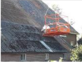
Foto: Golfplaten los schroeven
