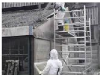
Foto: Golfplaat verwijderen
