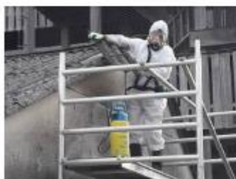
Foto: Golfplaat verwijderen
