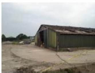
Foto: Overzicht schuur achterzijde
