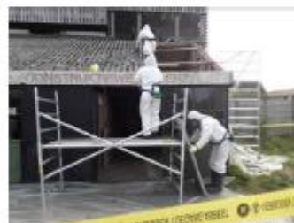
Foto: Golfplaten naar container brengen
