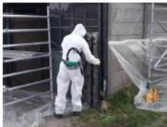
Foto: Golfplaat verzamelen tegen gevel
