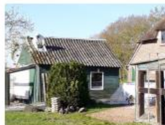
Foto: Golfplaten los schroeven
