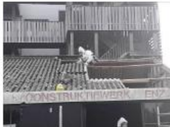
Foto: Golfplaat naar beneden schuiven
