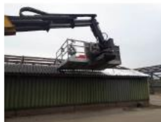
Foto: golfplaten inspuiten met schuim
