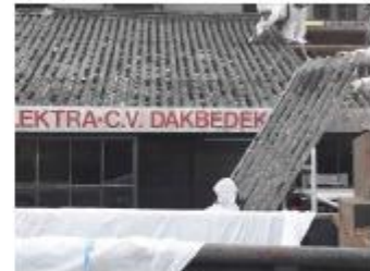
Foto: Golfplaten over steiger schuiven
