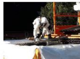
Foto: Golfplaten in container schuiven
