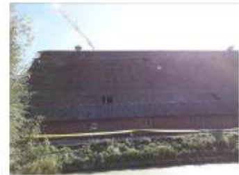
Foto: Overzicht na sanering
