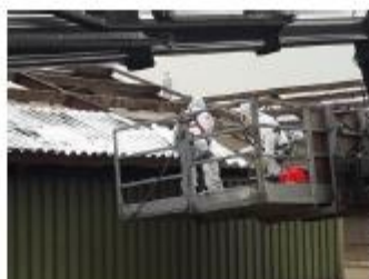
Foto: golfplaten verwijderen
