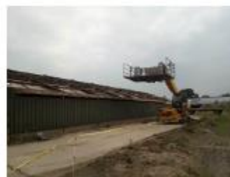
Foto: Eerder gesaneerde dak helft
