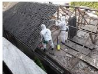
Foto: Golfplaat verwijderen
