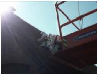
Foto: Golfplaten verwijderen
