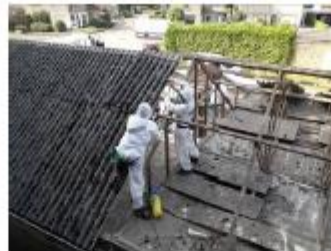
Foto: Golfplaat verwijderen
