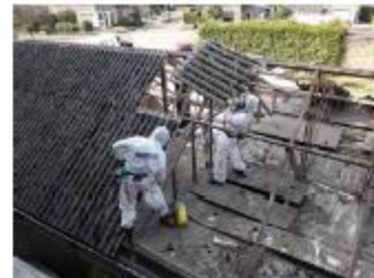
Foto: Golfplaat verwijderen
