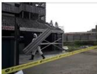
Foto: Golfplaten naar container brengen
