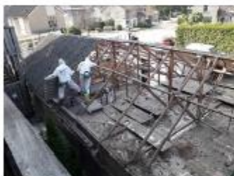
Foto: Golfplaat schuiven over loopplank
