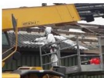
Foto: golfplaten inspuiten met schuim
