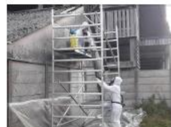
foto: Golfplaat doorsteken
