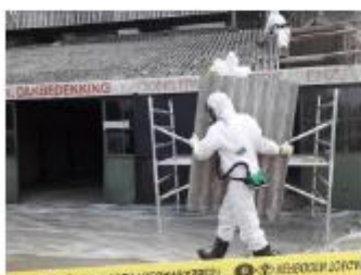
Foto: Golfplaten naar container brengen
