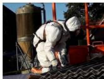
Foto: Golfplaten in container schuiven
