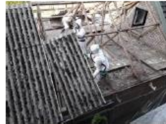
Foto: Golfplaat verwijderen
