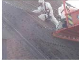
Foto: Golfplaten verwijderen
