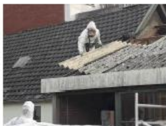
Foto: Golfplaat verwijderen
