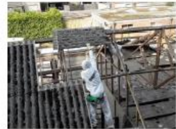
Foto: Loswrikken golfplaat
