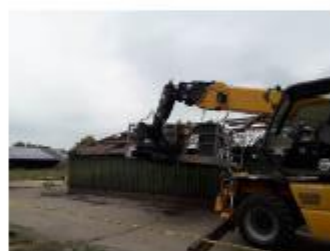
Foto: golfplaten los schroeven
