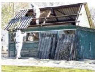
Foto: Golfplaten verwijderen
