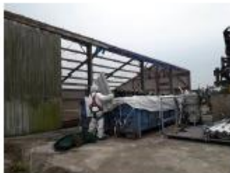
Foto: losse golfplaat in container gooien
