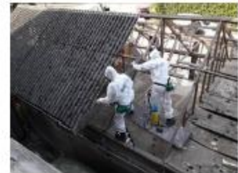
Foto: Golfplaat verwijderen
