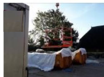
Foto: Nokvorsten naar container brengen
