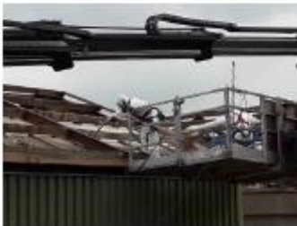
Foto: stofzuigen spanten
