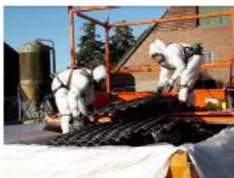
Foto: Golfplaten in container schuiven
