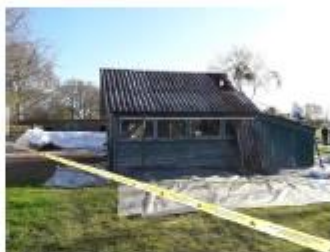
Foto: Overzicht golfplaten dak
