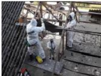
Foto: Golfplaat schuiven over gording
