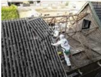
Foto: Golfplaat verwijderen
