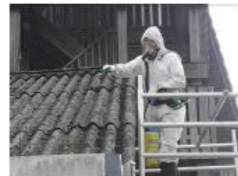
Foto: Dak benevelen
