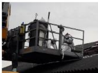
Foto: golfplaten verwijderen
