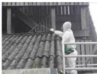
Foto: Dak benevelen
