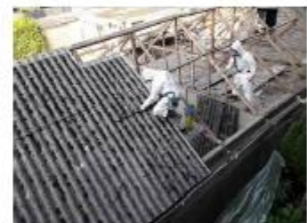
Foto: Golfplaat verwijderen
