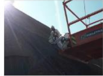
Foto: Golfplaten verwijderen
