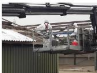
Foto: golfplaten verwijderen
