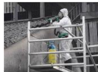
Foto: Golfplaat verwijderen
