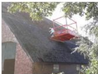
Foto: Golfplaten verwijderen
