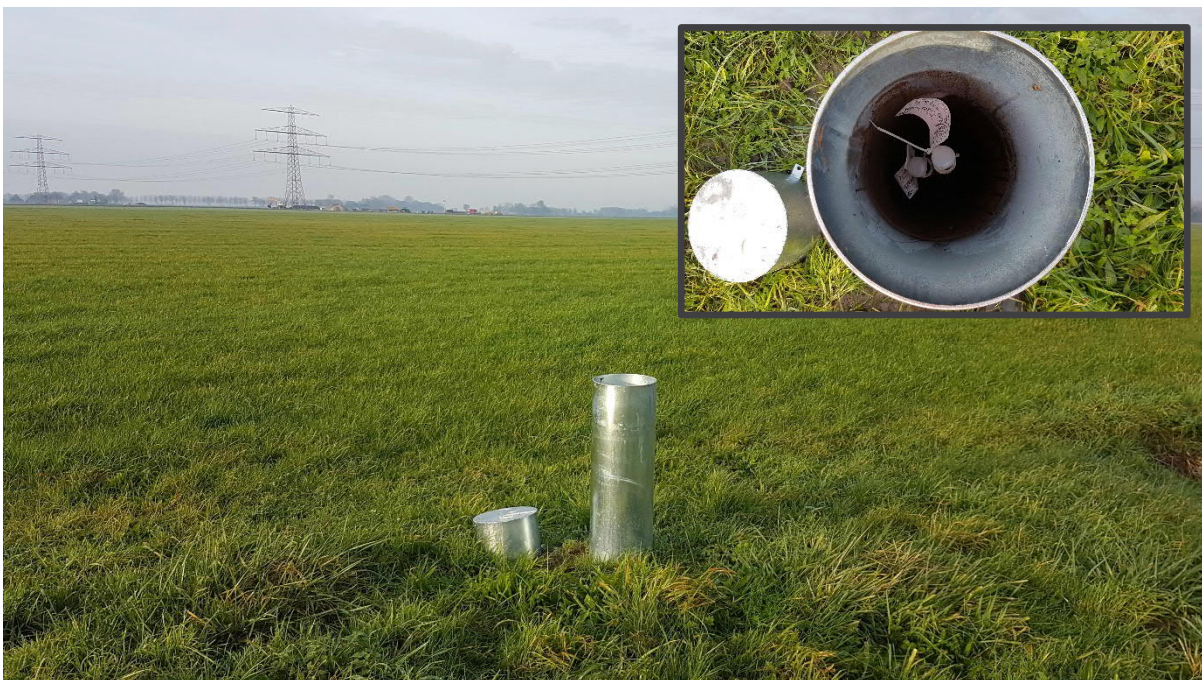
Fig. 2.4. Peilbuizen met beschermkoker locatie Godlinze (inzet foto is het bovenaanzicht)
