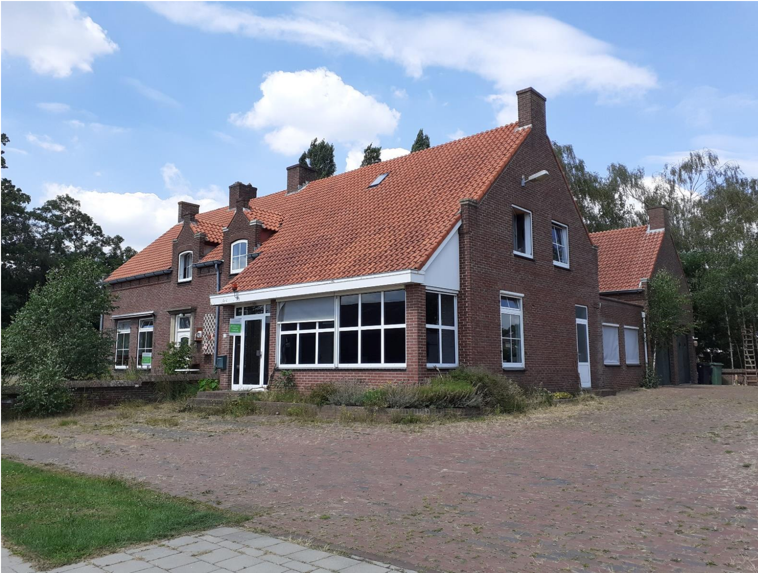
Figuur 16 Woningen van de steenfabriek Bloemenstraat 70 en 72 (karakteristieke panden)
