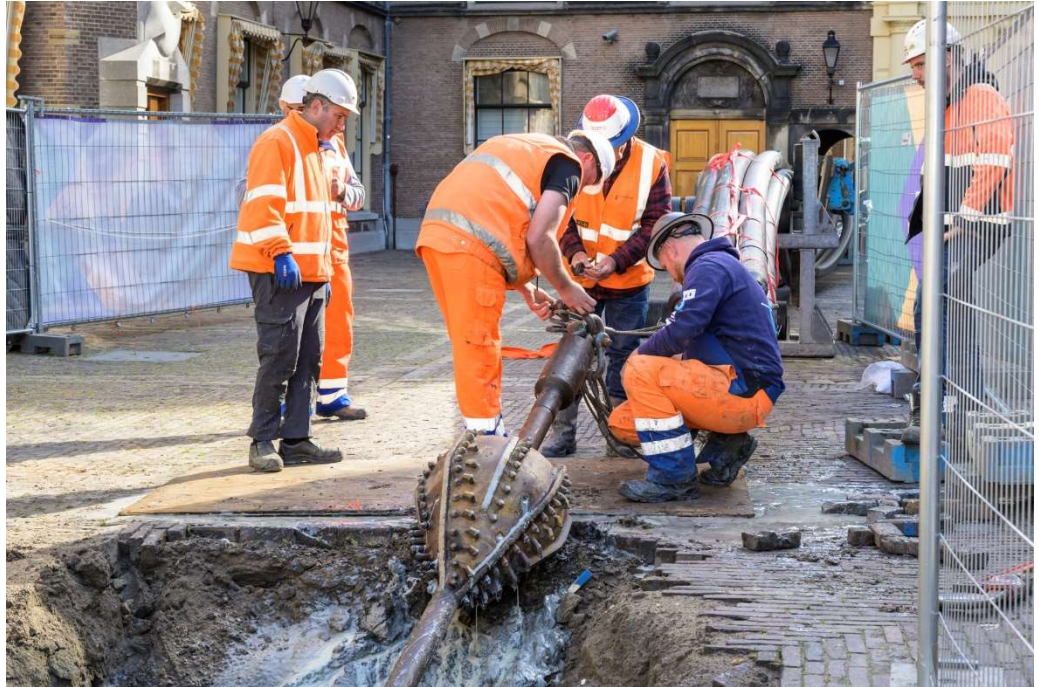
Werkzaamheden kabels en leiding, Tineke Dijkstra
