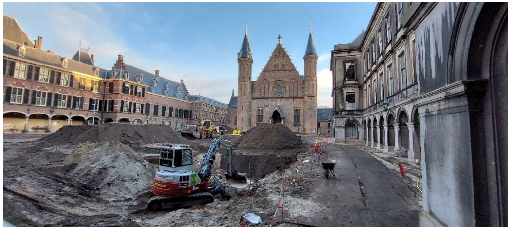
Werkzaamheden Opperhof, foto RVB
