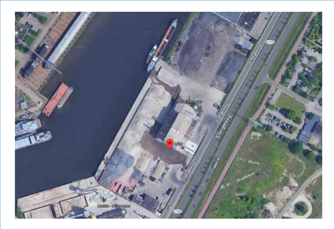
Figuur 8: Overzicht van het APN-complex aan de Oostkanaalhaven. Het centrale gebouw is de asfaltcentrale, eromheen liggen grondstoffen voor de productie van asfalt. (Bron: Google Maps)
