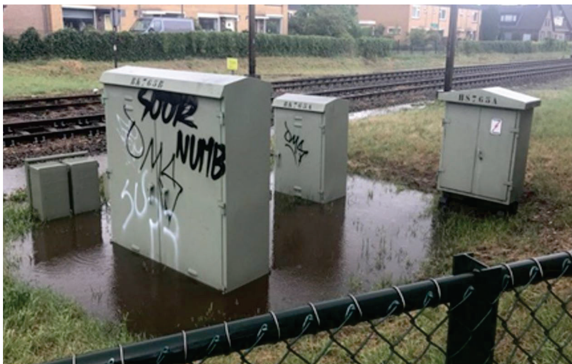
Afbeelding 10: Wateroverlast bij relaiskasten
