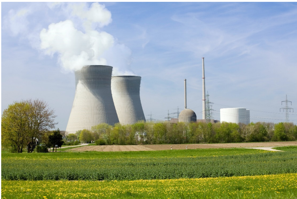
Figuur 5.5 Natte koeltorens zijn een bekende verspreidingsbron van de Legionellabacterie, die met de waternevel mee naar buiten kan komen. Bij natte koeltorens worden daarom biociden gebruikt, ook om aangroei te voorkomen zodat ze goed blijven functioneren.
