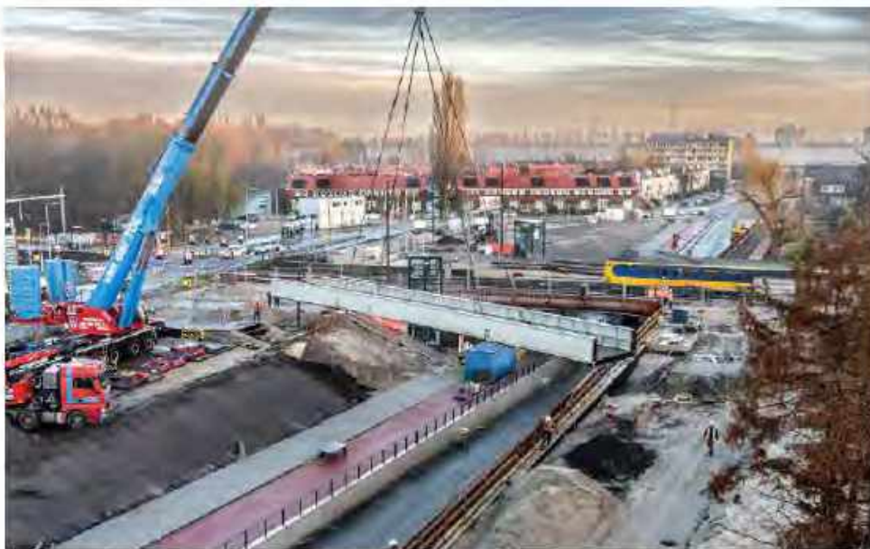
Wegtakelen van tijdelijke spoorbrug bij station Diemen.
