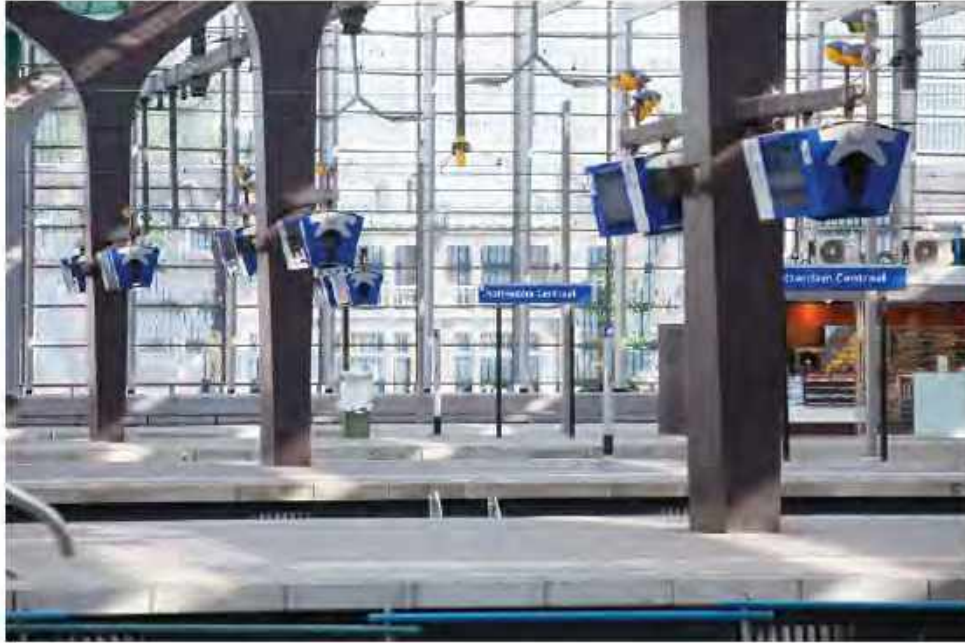
Perrons op station Rotterdam Centraal.
