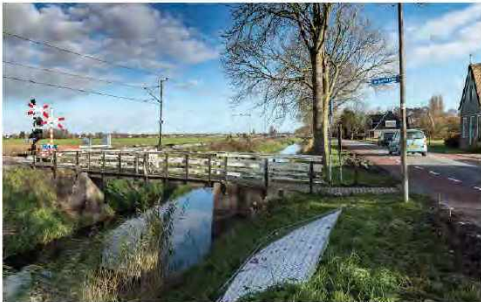
Overweg in Westwood tijdens verbetering van de beveiliging door middel van Automatische Overpadbomen.
