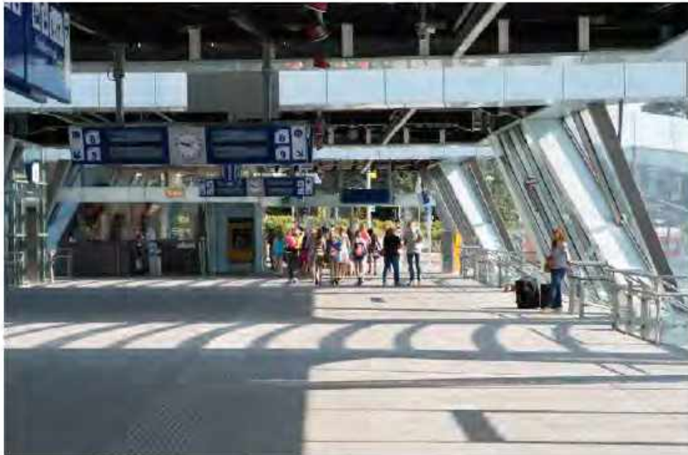
Reizigers op de voetgangersbrug op station Arnhem Centraal.
