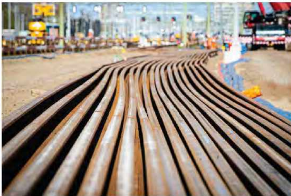
Werkzaamheden t.b.v. uitbreiding van sporen bij Zwolle.
