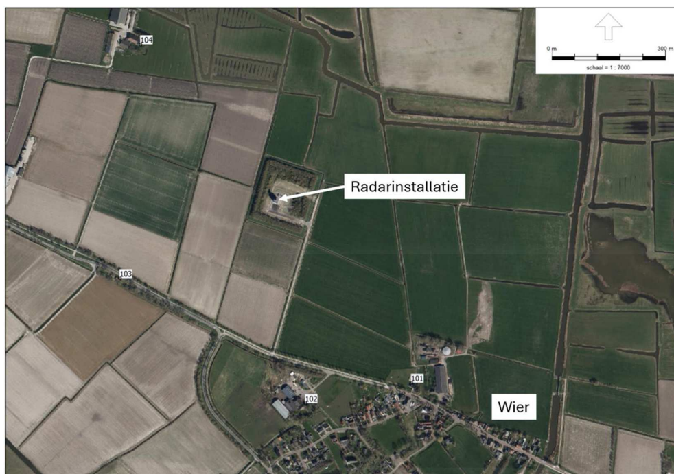
f 2.1 Situatie van de radarinstallatie te Wier
