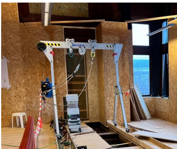
Veiligheidsportaal en proefopstelling warmte-element
