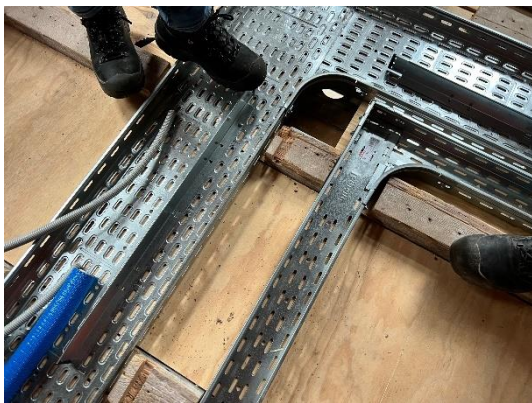
Proefopstelling leidingen en kabelgoten voor elektra
