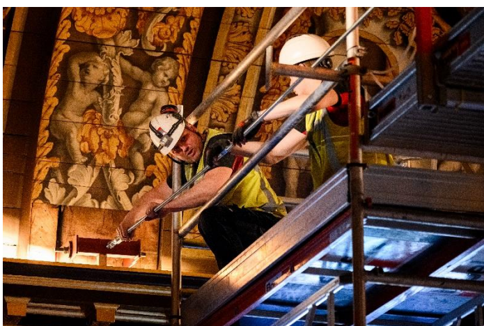
Aanbrengen tijdelijke trekstangconstructies ten behoeve van stabiliseren dakconstructie plenaire zaal EK (foto's: Artjen Veldt)
