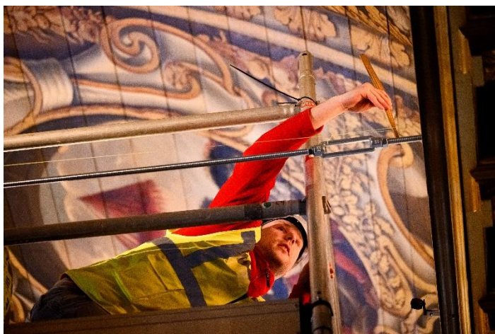
Aanbrengen tijdelijke trekstangconstructies ten behoeve van stabiliseren dakconstructie plenaire zaal EK (foto's: Artjen Veldt)
