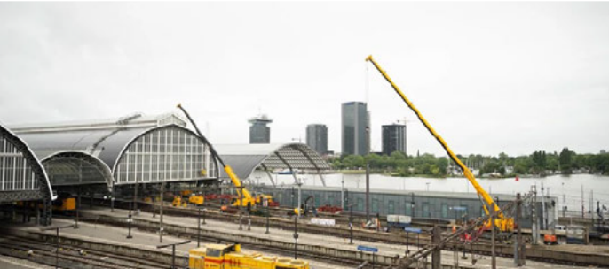
werkzaamheden op Amsterdam Centraal
