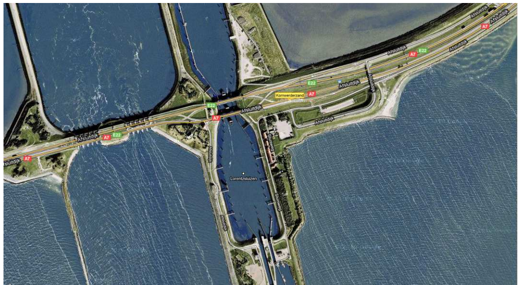
Schaalvergelijking: Naviduct bij Enkhuizen en Kornwerderzand
