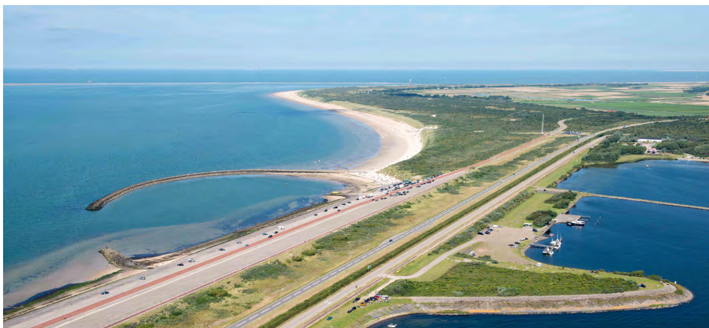
Brouwersdam (bron: https://beeldbank.rws.nl , Rijkswaterstaat)
