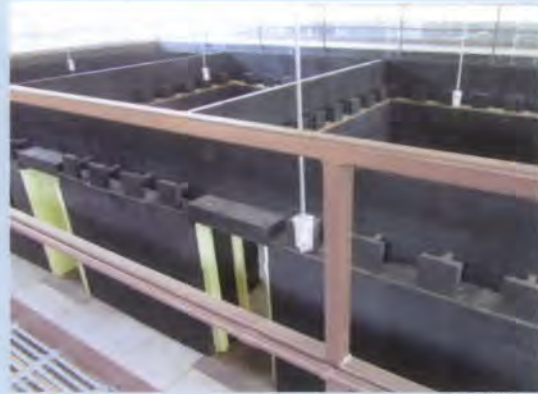
Figuur 10: Een voorbeeld van vaste kogelwerende binnenwanden van een schiethuis. (Foto: ministerie van Defensie).
