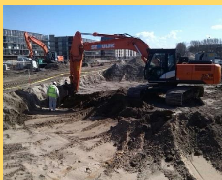
Bodemsanering Spoorzone Delft
