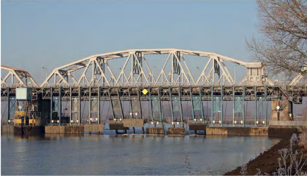
Figuur 12: Gele ruit op brug boven stuw.
