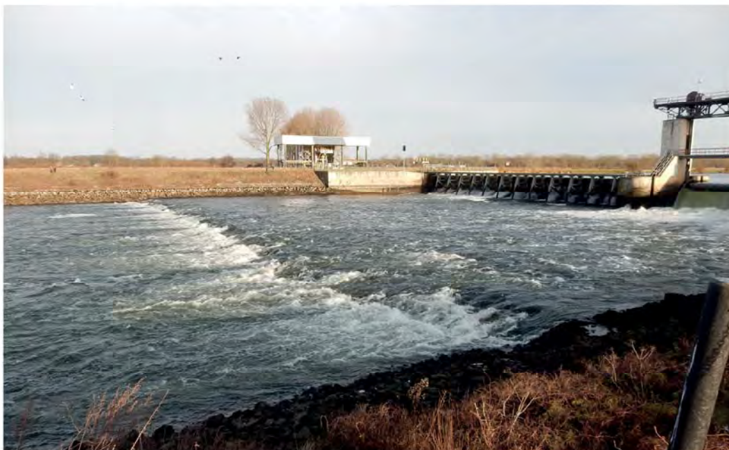
Figuur 20: Situatie met gedaald waterpeil benedenstrooms van stuw Sambeek. (Bron: Rijkswaterstaat)
