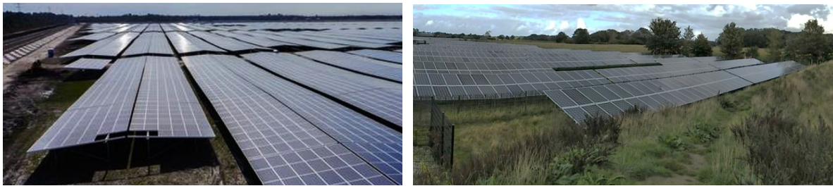
Figuur 23 Ten behoeve van de biodiversiteit is het belangrijk dat er voldoende licht en water op de bodem komt. Zuid geëxponeerde panelen (rechts) voldoen daar doorgaans beter aan dan oost-west geëxponeerde panelen (links).
