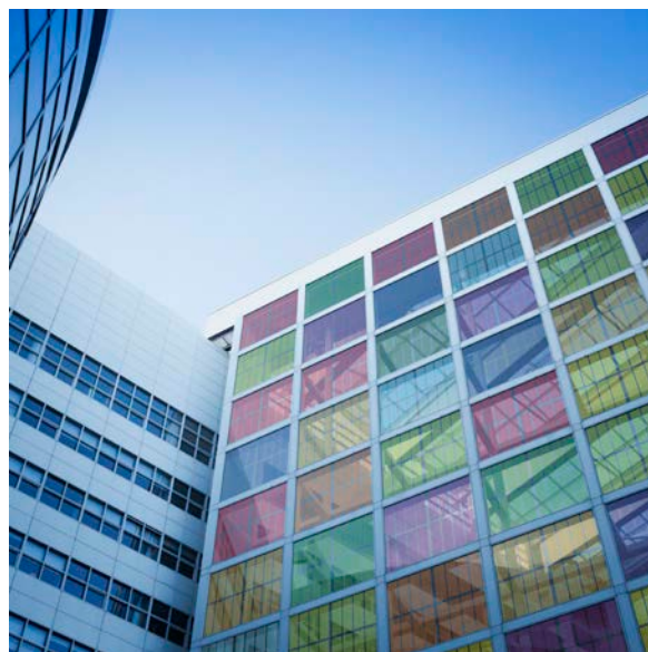
Figuur 5.10: Verschillende kleuren van keramische zonnepanelen zoals ontwikkeld door het Nederlandse Kameleon Solar (links) [bron: www.kameleonsolar.com ], en transparante PV zoals toegepast in het Imec-gebouw [bron: https://www.solarpowerworldonline.com ]
