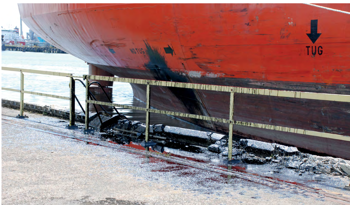
Figuur 11: Schade aan de rand van het overhangende steigerdek. (Bron: Zeehavenpolitie Rotterdam)
