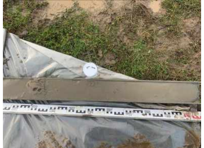
Foto 20 - Plaatsing peilbuis 101 (9 - 10 m-mv)
