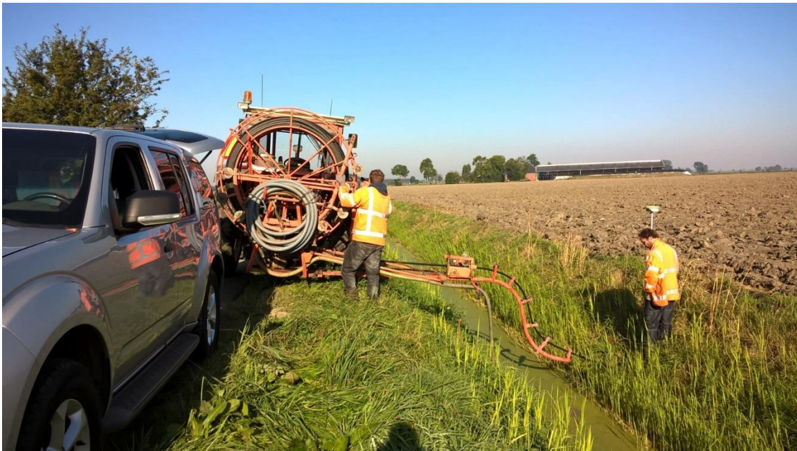
Fig. 2.5. Inbrengen van meetslang met drainreiniger (meting 2016)
