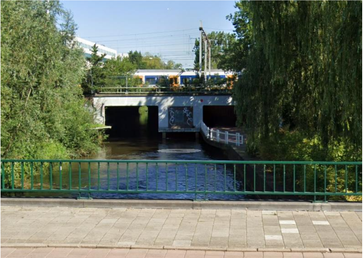
Huidige beeld Dommelpassage vanuit het zuiden (Stationsweg).
