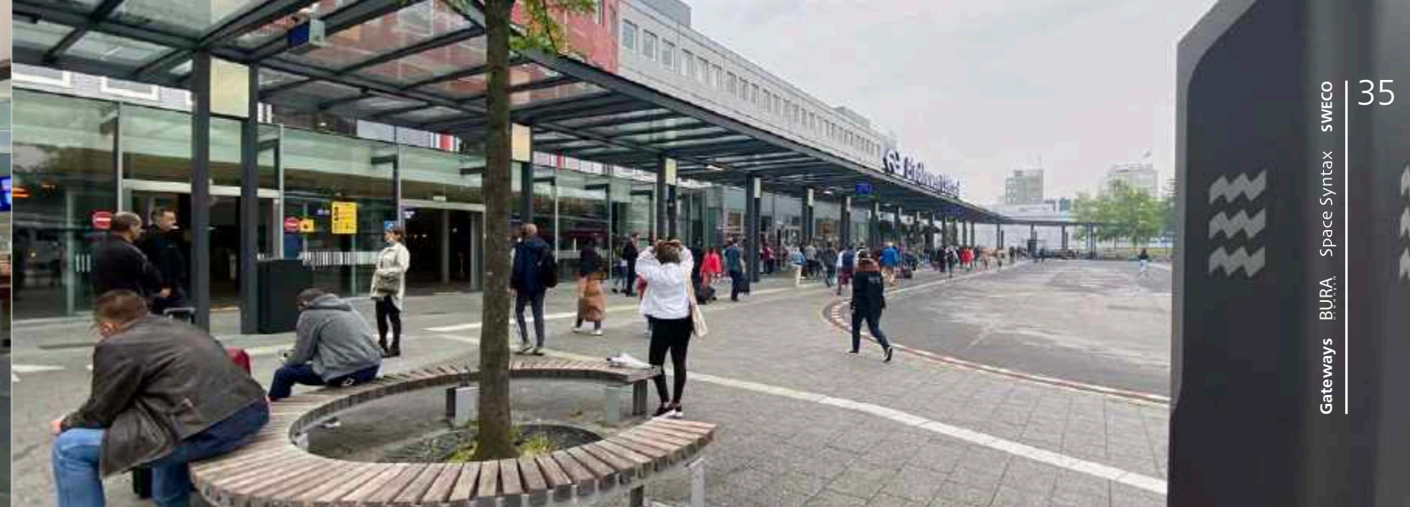
10. Gebouw Noordzicht met wachtruimte
