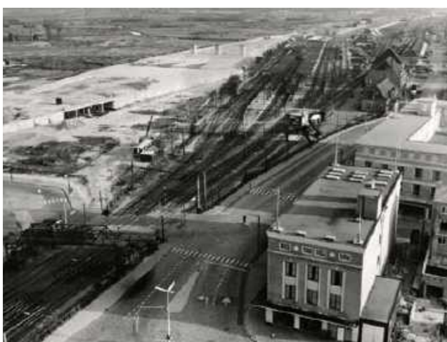
Ca. 1949, h Het spoor is nog niet verplaatst, de grond voor het nieuwe station is al bouwrijp gemaakt
