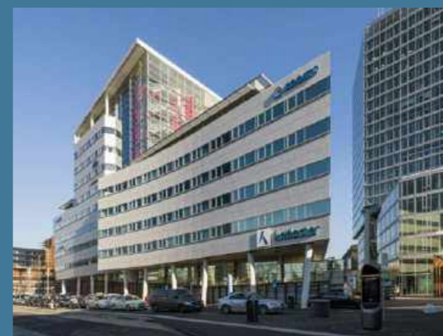
Beperkte kwaliteit van enkele plinten (huidig)
