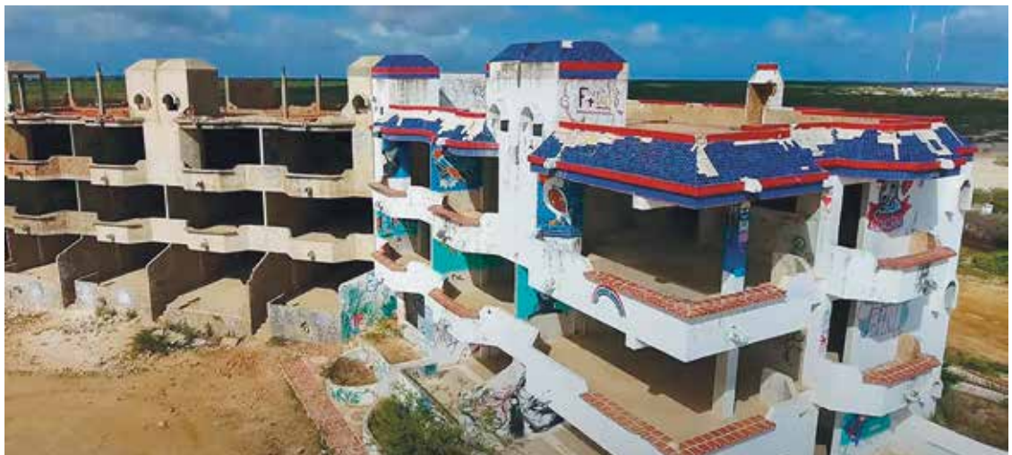
Figuur 2 Bivaklocatie 'Hotel Esmeralda', Punt Vierkant, Bonaire (bron: instructie aanbrenge valbescherming, Genie)
