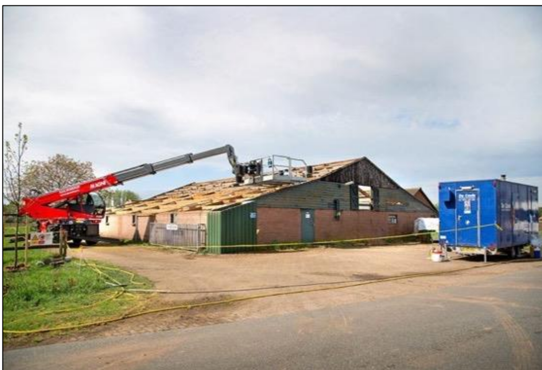
Foto: Saneren van een asbestdak van golfplaten
