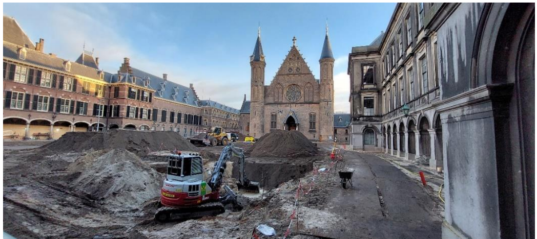
Werkzaamheden Opperhof, foto RVB
