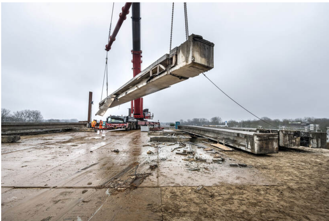
Foto Herbruiken viaduct van de oude A9 dat over de Gaasperplas- metrolijn ligt
