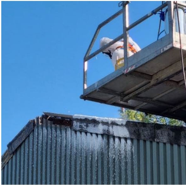
Foto 5: Beginnen met het inschuimen van de asbestcement golfplaten (nokstukken zijkant) op de verreiker
