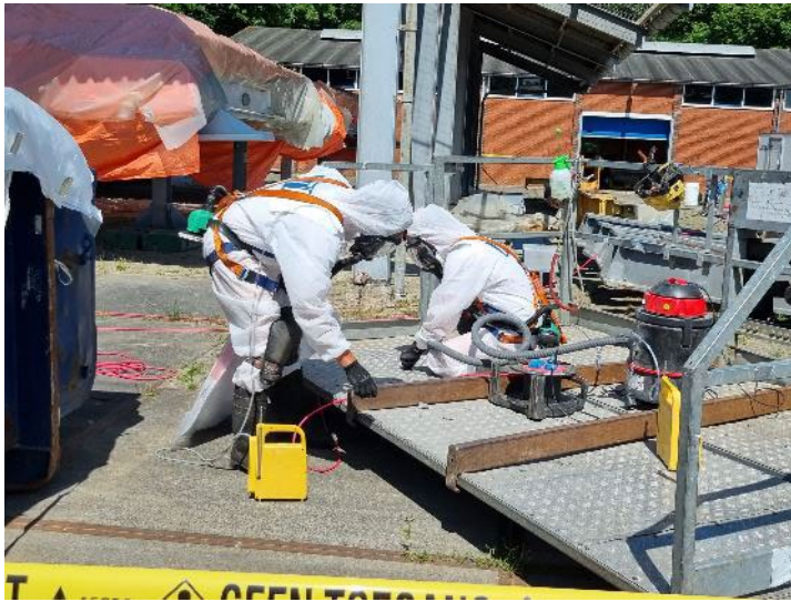
Foto 41: Schoonmaakwerkzaamheden, oprapen brokstukjes (handpicking, links) en stofzuigen bak verreiker (rechts)
