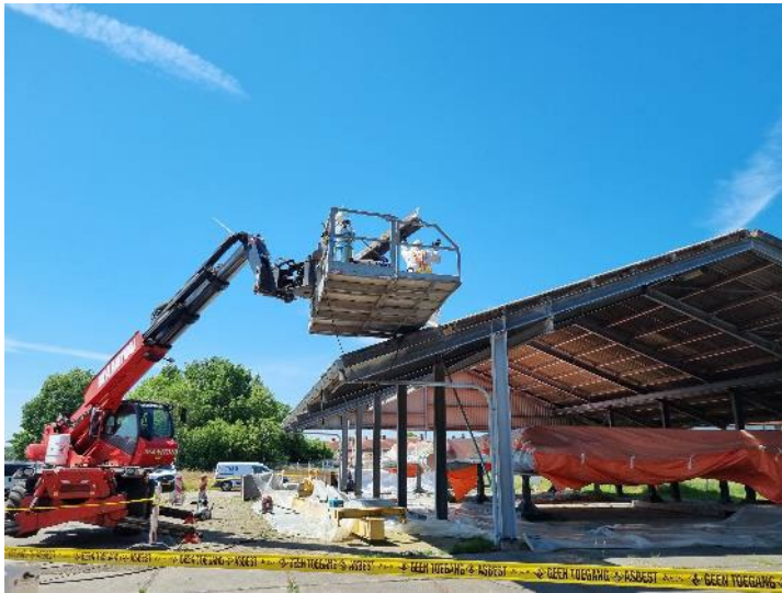
Foto 27: Plaatsen verwijderde asbestcement golfplaat (nokstuk) in de bak van de verreiker
