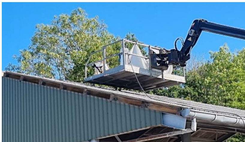
Foto 14: Oppakken asbestcement golfplaat vanuit verreiker
