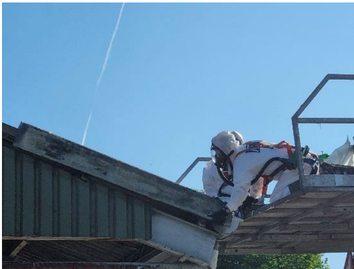
Foto 10: Verwijderen nokstuk aan de zijkant
