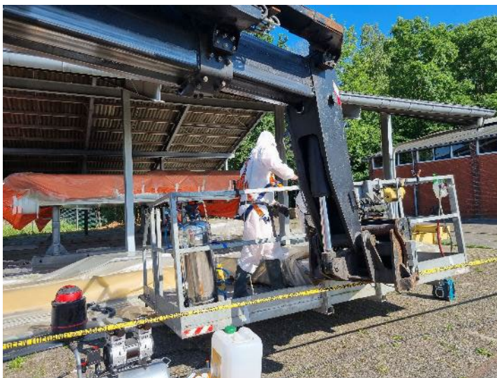
Foto 18: Inpakken verwijderde asbestcement golfplaten
