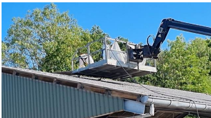
Foto 15: Verplaatsen (schuiven) asbestcement golfplaat naar bak verreiker
