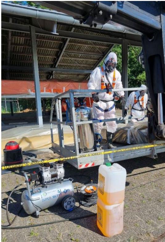
Foto 3: Containers met FoamShield (schuimmiddel)
