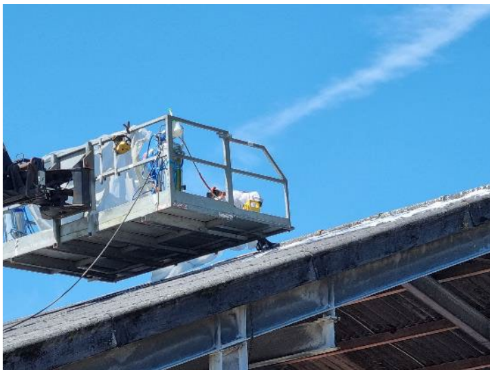
Foto 26: Losschroeven dakbouten de uit de asbestcement golfplaat (nokstuk)
