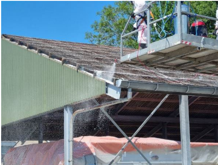
Foto 35: Inschuimen dakspanten.
