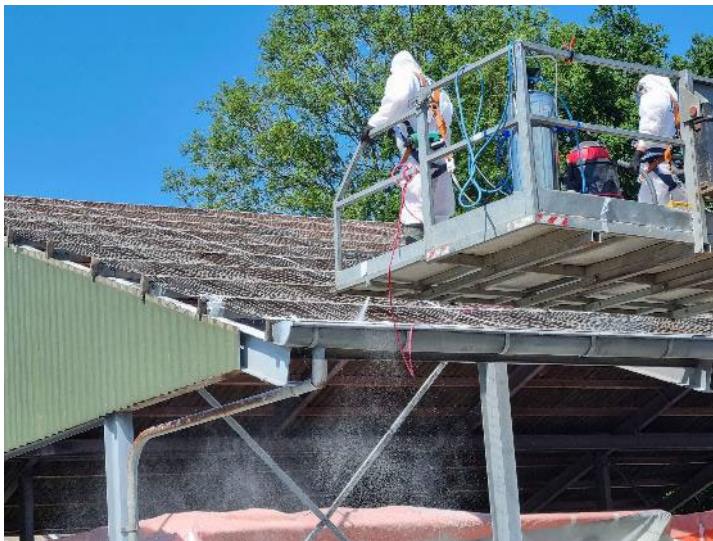
Foto 34: Inschuimen dakspanten. Nadat de asbestcement golfplaten zijn verwijderd, was er een soort “kippengaas” te zien die vast zat aan de dakspanten.
