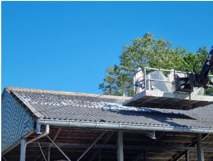
Foto 12: Vooraanzicht asbestdak, deel van de golfplaten zijn verwijderd (met name nokstukken aan zijkant en voorkant).
