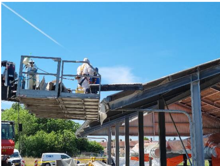
Foto 30: Verplaatsen nokstuk naar de bak van de verreiker
