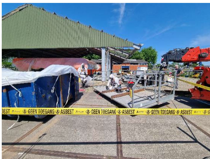
Foto 40: Schoonmaakwerkzaamheden, oprapen brokstukjes (handpicking, links) en stofzuigen bak verreicher (rechts)
