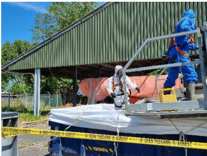
Foto 32: Verplaatsen verwijderde nokstuk van de bak van de verreiker naar de afvalcontainer
