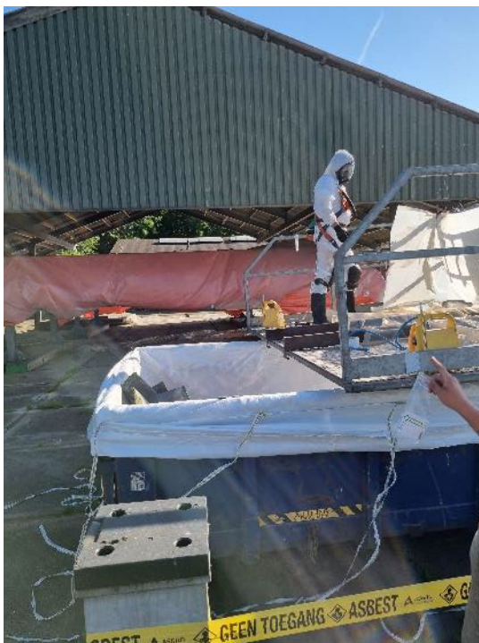
Foto 11: Plaatsen verwijderde nokstukken e.d. in de afvalcontainer
