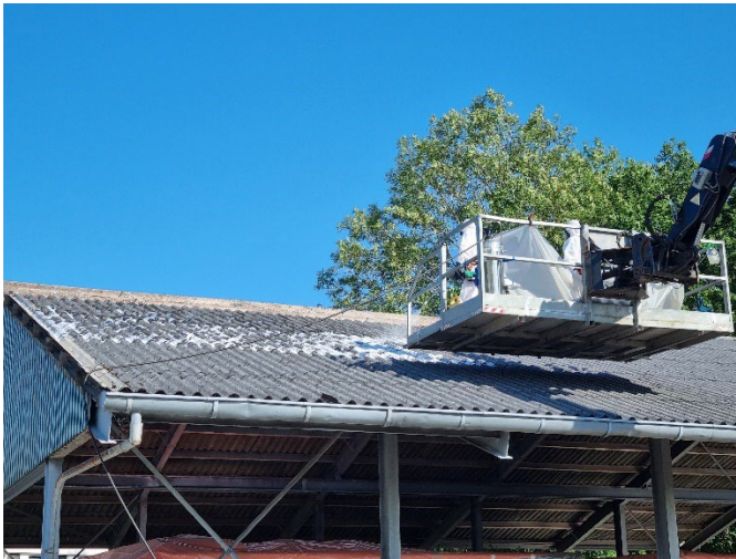
Figuur 2: Foto tijdens verwijderen van asbestcement golfplaten met behulp van de FoamShield methode op 13 juni 2023
