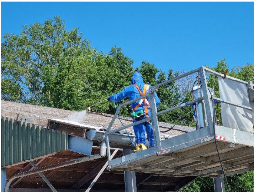
Foto 22: Inschuimen asbestdak vanuit verreiker
