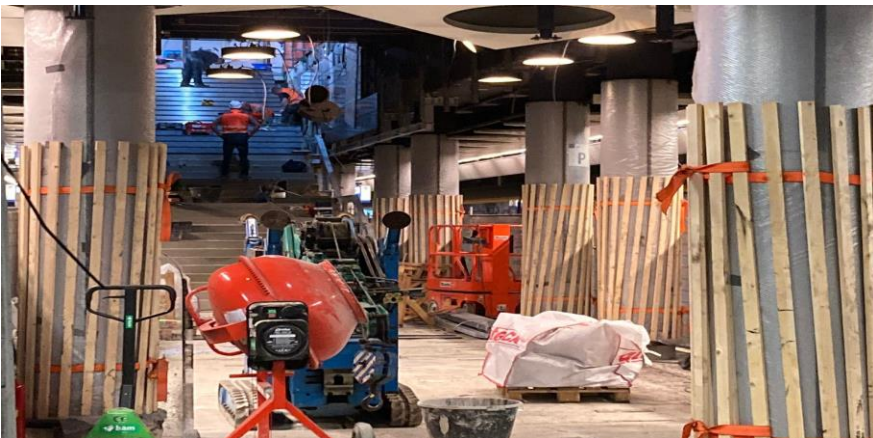
Op station Schiphol Airport worden de stijpunten vervangen ter vergroting van de transfercapaciteit (ruimte op het perron en doorstroming voor uitstappende reizigers).
