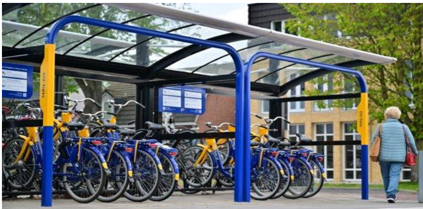
In 2023 zijn op meerdere locaties OV-fietsen met een slim slot geplaatst in nieuw ontworpen paviljoens.
