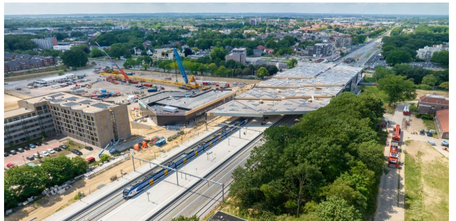
Station Ede-Wageningen is in 2023 ingrijpend vernieuwd. De verbreding van de perrons is daarin meegenomen.
