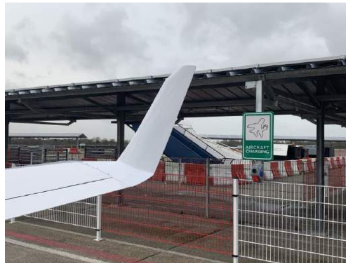
Figuur 4.7: Stroomvoorziening ten behoeve van laadvoorzieningen van elektrische vliegtuigen op Groningen Airport Eelde [59]
